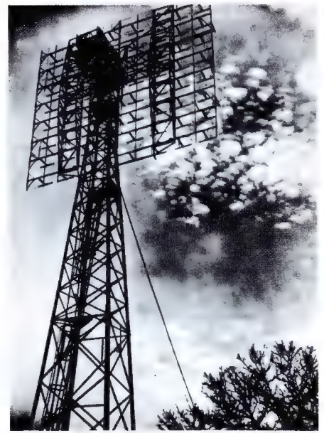
Bild 2. Die Radarantenne für die historischen Radarechoversuche in Belmar, N. J. aus dem Jahre 1946
