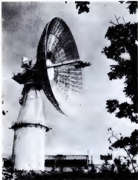
Bild 1. 25-m-Anlage auf dem Millstone Hill bei Westford/Massachusetts. Mit diesem Gerät wurden u. a. im Frühjahr 1958 Radarechos von der Venus erzielt
